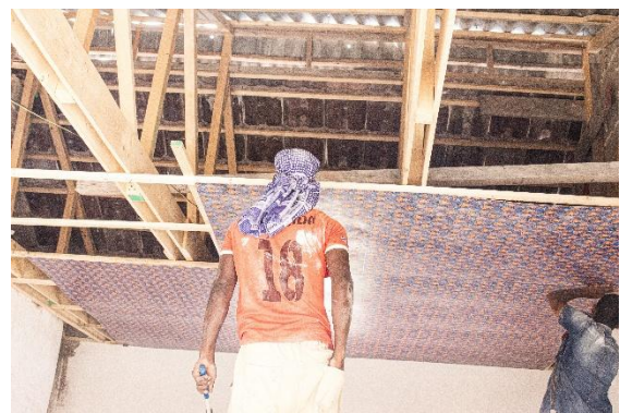
Neuer Dachstuhl wird beim Ambulatorium von Swisso Kalmo in Merka aufgerichtet
