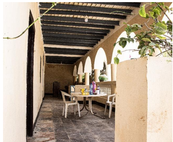
Die fertig renovierte Veranda
